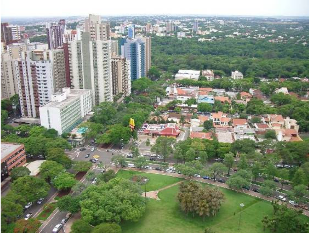
Figura 10. A presença de construções maiores convive harmoniosamente com a vegetação viária, dando à cidade paranaense um aspecto único pela confraternização entre o elemento construído e o natural.
